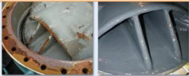
De gecorrodeerde vlinderklep – voor en na reparatie
