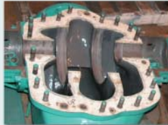
Reparatie volledig uitgesleten oppervlak
